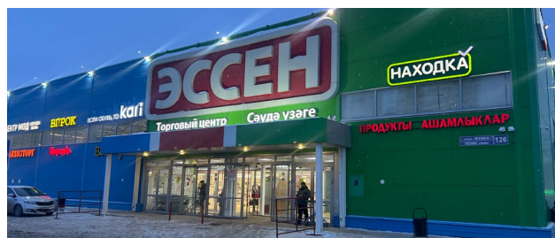
Массивная основная вывеска избыточного размера непропорциональна высоте здания.
