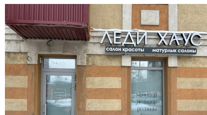
Вывеска вписана в зону для вывесок, не перекрывает архитектурные элементы.
