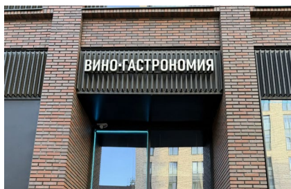
Москва. Вывеска встроена в специально отведенную проектом нишу над проемом.
