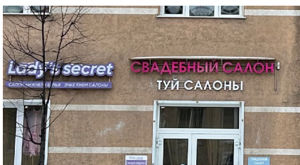
Две вывески размещены на одной оси, единой высоты.
